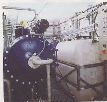
Bild 4: Schaltkasten und Vorlagetank
